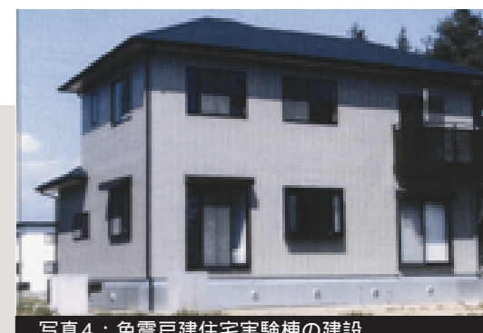
写真4：免震戸建住宅実験棟の建設
