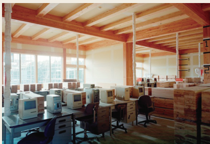
写真1 準備実験の木造校舎の内部 （壁・天井は不燃材料仕上げ）
