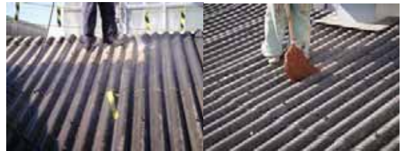
図 1 下地調整の状況（左：高圧水洗、右：棕櫚箒）
