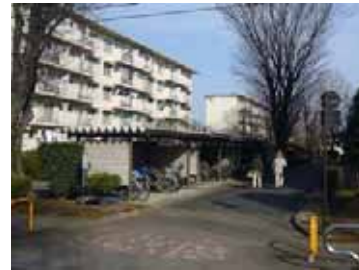
写真2 対象とする中層団地（同上）
