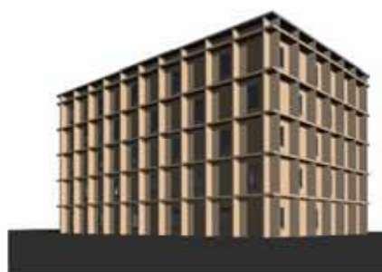
図2 試設計を行った CLT 構造による 5 階建て事務所ビルのパース
