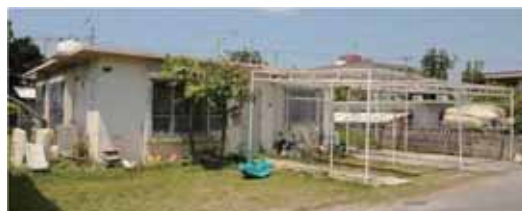
写真 5 RC 造住宅 (米軍型住宅)
