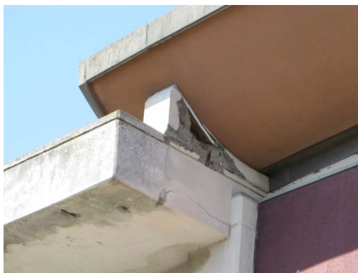
写真 4.3-3 外部の屋根支承部
