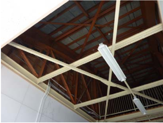
写真 4.2-5 屋根面水平ブレース（損傷なし） 写真 4.2-6 鉄骨屋根の接合部（損傷なし）
