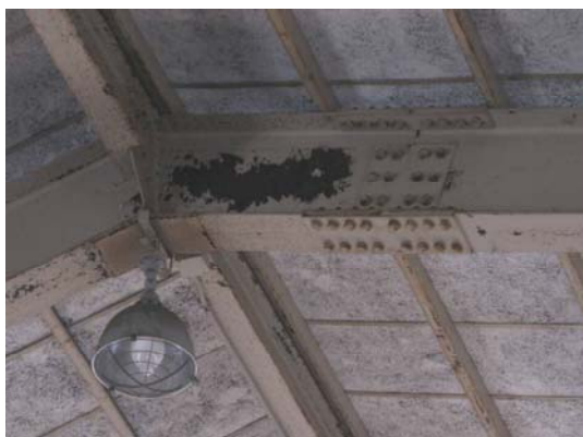
写真 4.2-16（左）、写真 4.2-17（右） 梁ウェブの降伏によると見られる塗装の剥がれ
