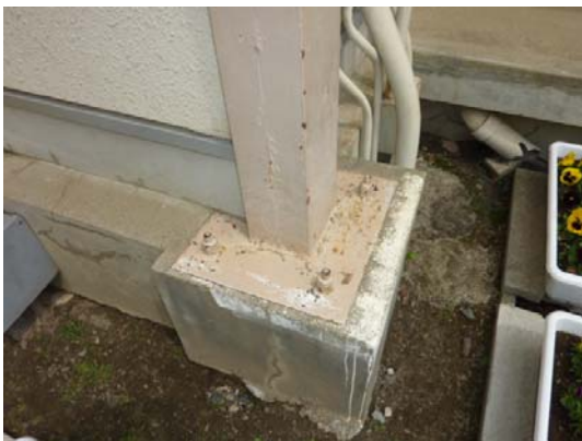
写真 4.1-23 柱脚（損傷なし）
