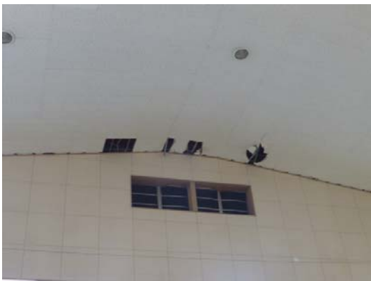
写真 4.2-7 天井の損傷
