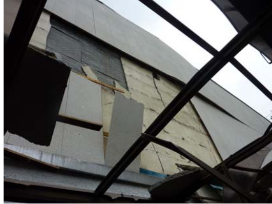
写真 4.1-14 外壁の脱落
