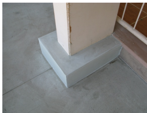
写真 4.3-17 柱脚部（修復済み）
