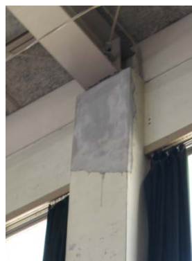
写真 4.3-12 屋根支承部 (灰色部分が修復箇所)
