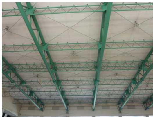
写真 4.2-11 屋根面の鉄骨トラスと水平ブレース (損傷なし)
