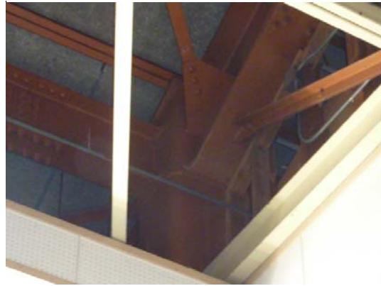
写真 4.2-5 屋根面水平ブレース（損傷なし） 写真 4.2-6 鉄骨屋根の接合部（損傷なし）
