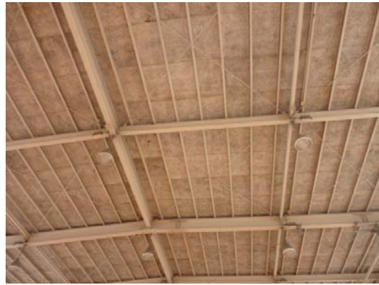
写真 4.1-22 屋根面水平ブレース（損傷なし）
