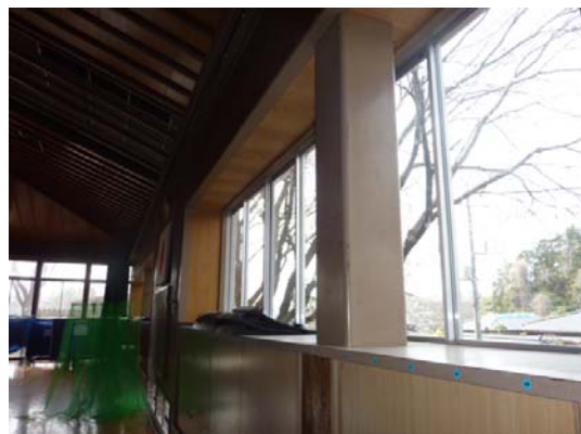
写真 4.1-28 角形鋼管柱（損傷なし）
