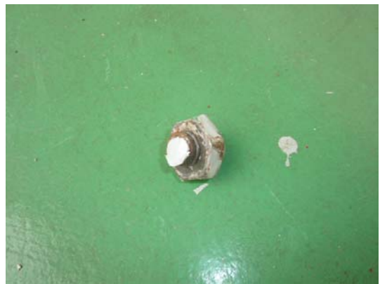
写真 4.1-10 破断したボルト
