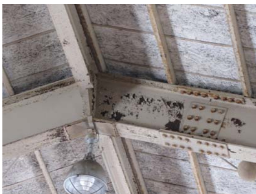
写真 4.2-16（左）、写真 4.2-17（右） 梁ウェブの降伏によると見られる塗装の剥がれ
