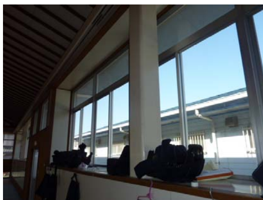
写真 4.2-22 角形鋼管柱（損傷なし）
