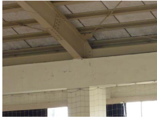
写真 4.1-26 屋根支承部（損傷なし）
