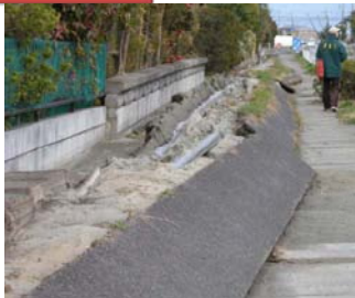
地盤の液状化による被害
