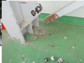
ブレース材の接合部の破断
