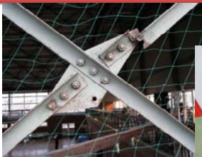
ブレース材の接合部の破断
