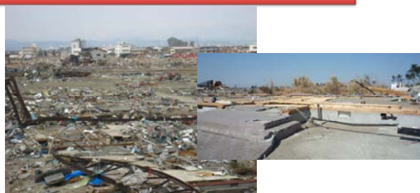
浸水深の高い地域における全面的な流失
