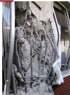
旧耐震基準による建築物の柱のせん断破壊による被害
