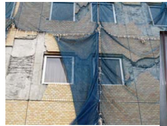
非構造部材の被害(外装材、マンション玄関周り)
