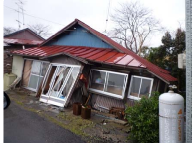
地盤変状に伴う住宅の被害
