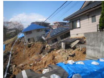
地滑りによる被害
