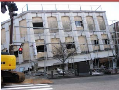
旧耐震基準による建築物の柱のせん断破壊による被害
