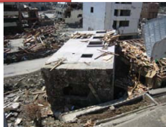
転倒・移動した建築物
