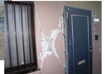
非構造部材の被害(外装材、マンション玄関周り)
