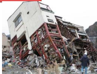
柱座屈等による傾斜・転倒
