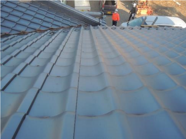
写真 2.6.3 損傷が無い平部
