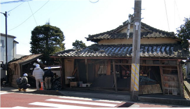
写真 3.1.1 大きな残留変形のある木造住宅
