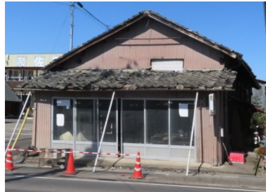
写真 3.1.4 倒壊防止の応急補強を施された木造住宅
