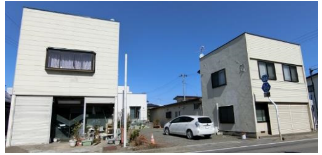
写真 3.1.8 無被害又は被害軽微と見られる店舗併用住宅
