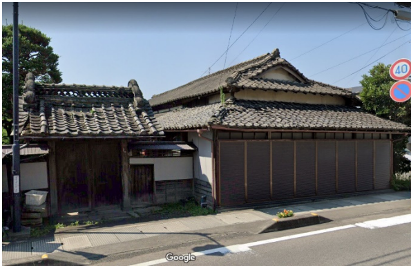
写真 3.1.3 写真 3.1.1～3.1.2 の被災前 (Google ストリートビュー(2019年8月撮影)より)
