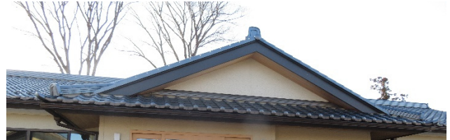
写真 2.6.2 住宅⑥の屋根の外観 2
