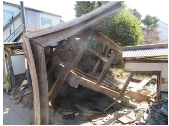
写真 3.1.2 倒壊した門（写真 3.1.1 の左側）
