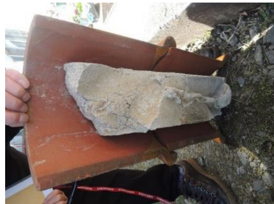
写真 2.9.2 写真 2.9.1 に示す棟部の冠瓦
