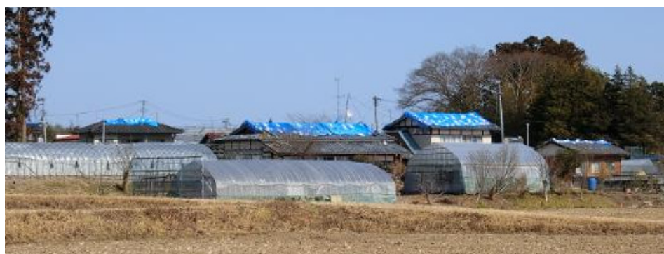
写真 2.9.8 散見された屋根瓦の被害
