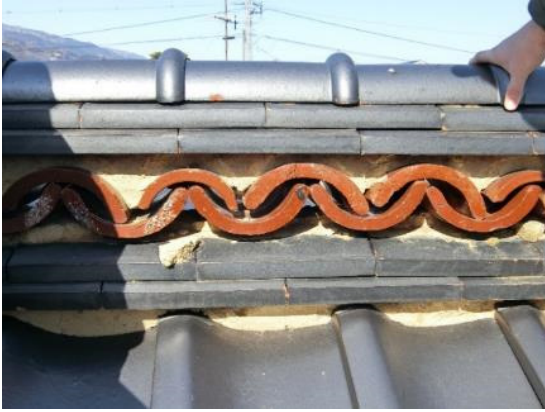
写真 2.4.5 付属の平屋の棟部
