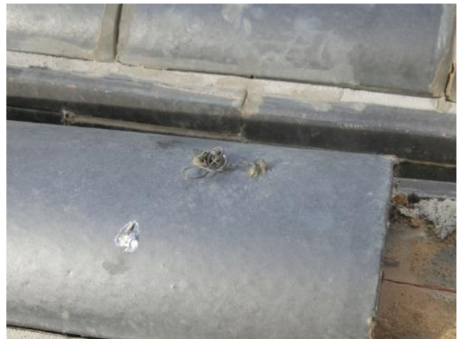
写真 2.7.4 棟瓦の緊結線
