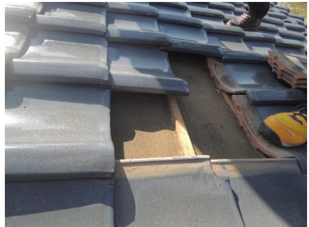
写真 2.1.2 椽瓦を一部撤去した状況
