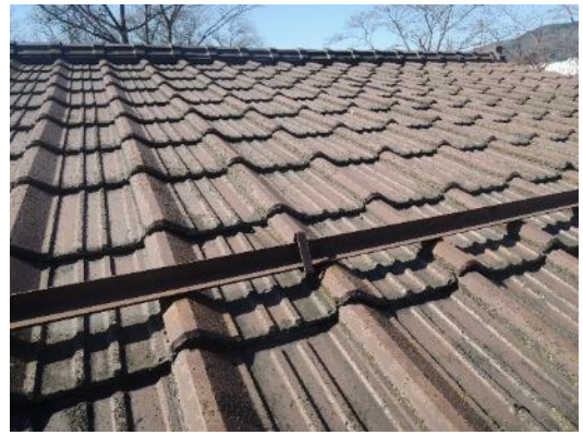
写真 2. 2. 4 セメント瓦による 2 階部分の状況
