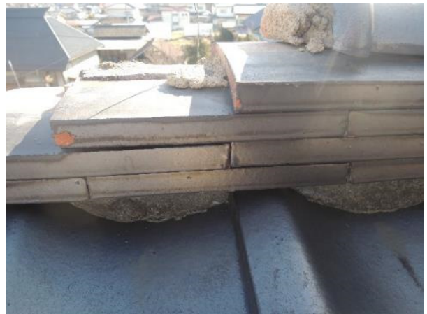
写真 2.5.2 棟部ののし瓦と冠瓦の状況
