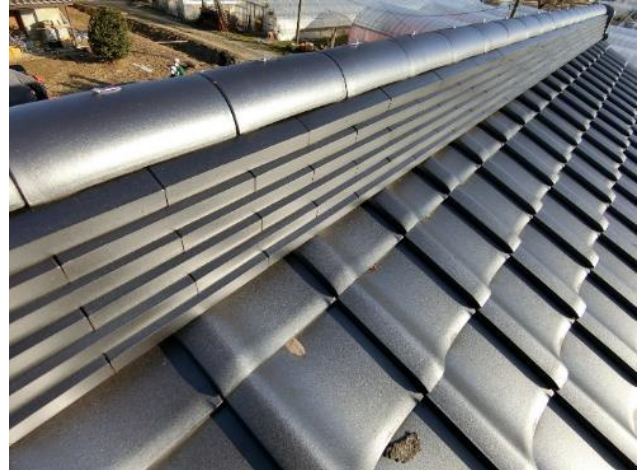
写真 2.6.4 損傷が無い棟部
