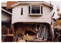
耐力壁の不足 被災危険部位・耐震性能向上に寄与する部位の抽出方法
