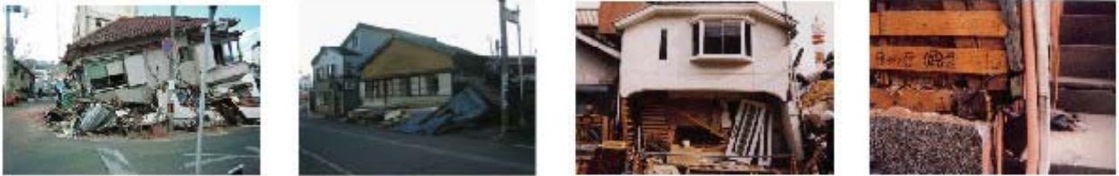
層崩壊（左：兵庫県南部地震 右：新潟県中越地震） 壁の損傷 接合部等の損傷 木造住宅の地震被害
