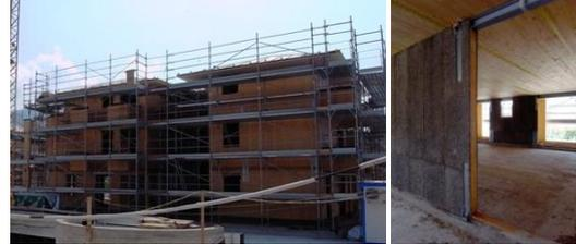
欧米で建設されているクロス・ラミネーテッド・ティンバーを構造材とする建物。日本では、同材料を認定するための枠組がない。
