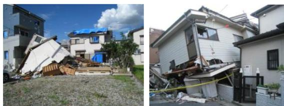
写真3 木造住家の上部構造の倒壊
