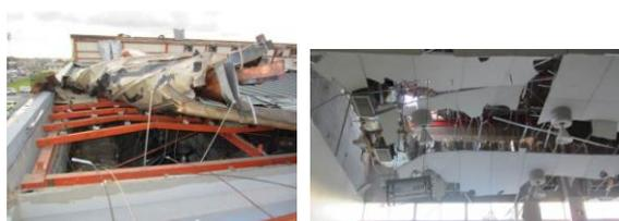
写真2 鉄骨造の文教関連施設の屋根ふき材と天井材の被害
