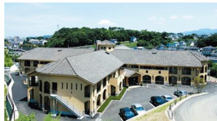
2 × 4 工法による耐火構造でつくられた大規模木造建築物。防火規定により木造には厳しい制限があり、高い耐火性能が要求される。
