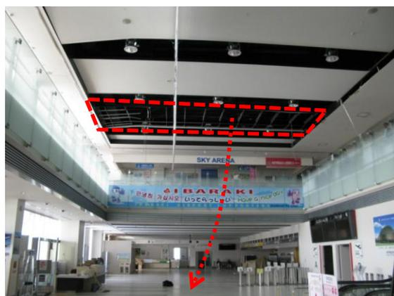
写真1 東日本大震災での天井脱落被害例
