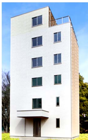
写真2. 枠組壁工法による6階建て実験棟
