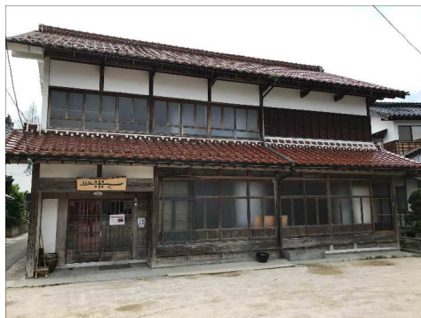
写真1 昭和20年代の古民家を改修した「えん処米や」全景
