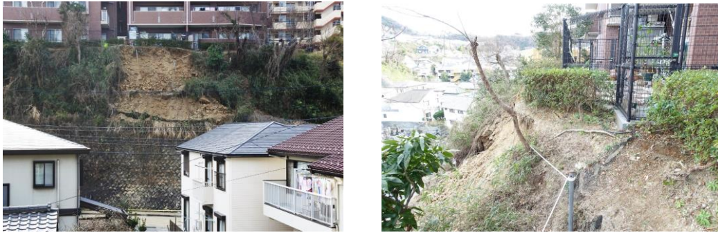
写真-I-1. 2. 4 土砂崩れ箇所の様子
