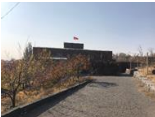
写真-I-2. 1. 1 アルメニアの国立地震災害調査研究所の外観
