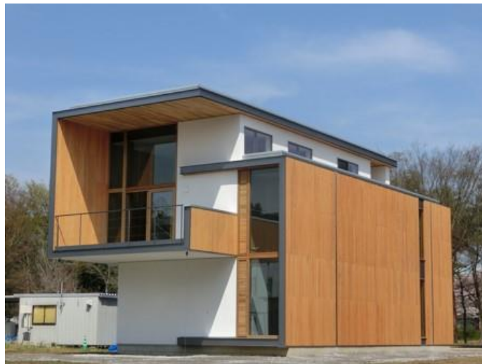
写真-I-1. 2. 15 CLT 実験棟
