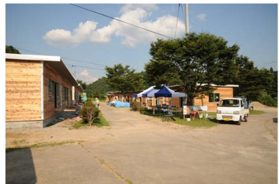
図3 地元工務店建設の木造仮設住宅（三春町）
