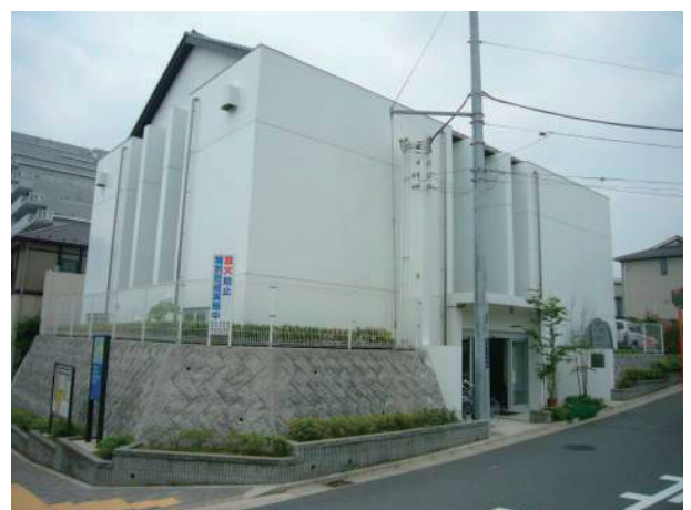
写真一6 エリマネの拠点となる町内会館 (新百合山手地区)
