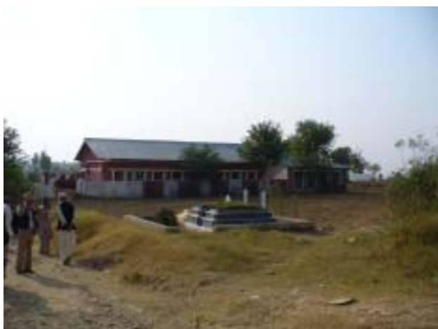
写真45 州立女子小学校 (左側がRC造、右側(妻面が見える)がブロック造)
