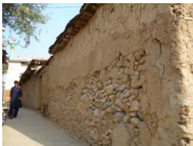
写真48 石造住宅左側側面
