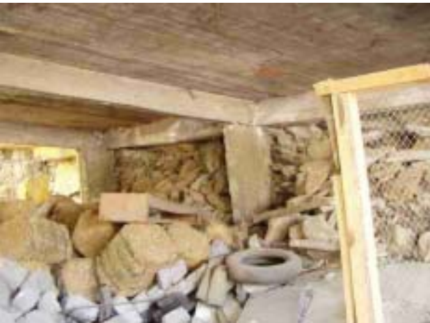
写真24 写真23の建物の1階内部
