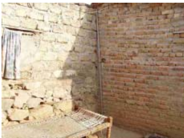
写真55 住宅内部（屋根は崩落）左側壁の下部は丸石、上部は切石、右側はレンガとなっている。
