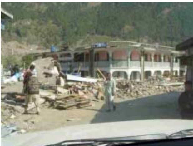
写真10 マンセラ市内の崩壊建物と被害の少ない建物
