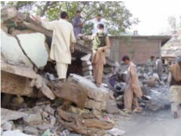
写真5 被災者の活動状況
