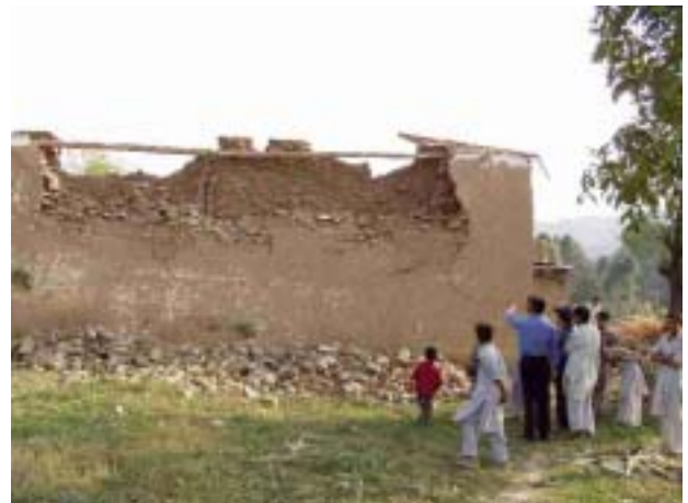
写真53 複数種類の材料による組積造住宅
