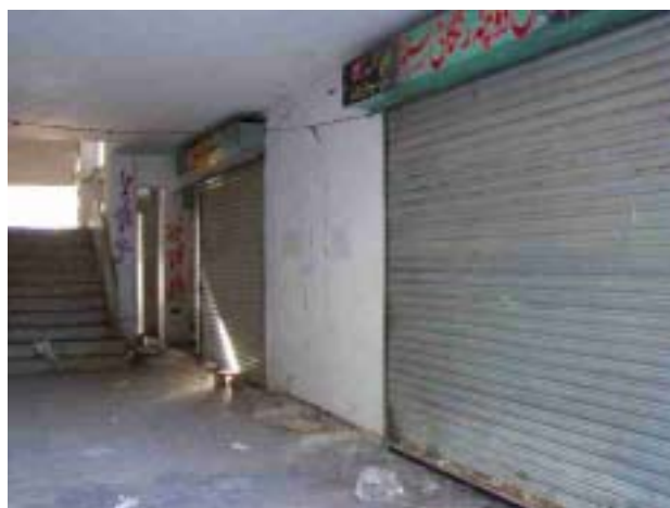
写真21 写真19の建物の内部
