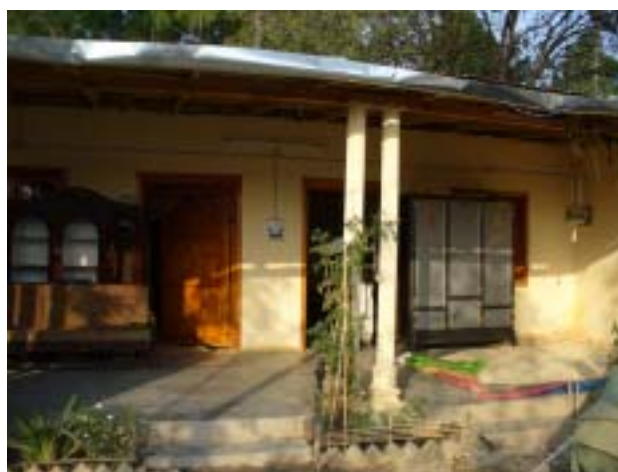
写真57 ブロック造壁構造住宅
