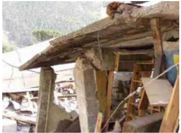
写真16 バラコート 柱頭部の破断状況
