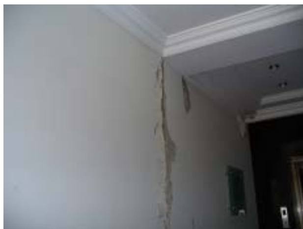
写真3 4 オフィスビルの内部
