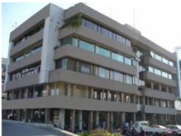
写真3 3 イスラマバードのオフィスビル
