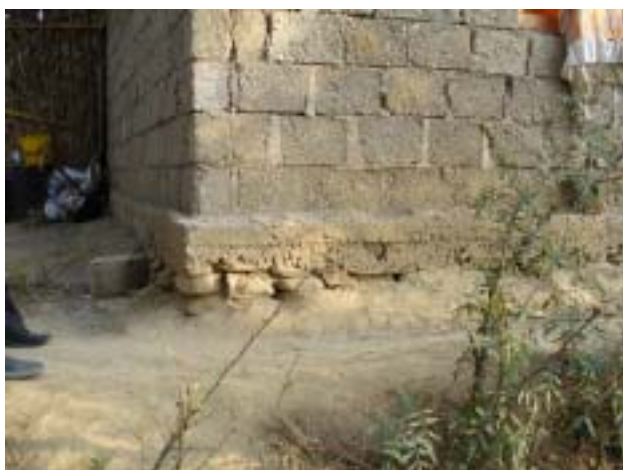
写真59 基礎の割り栗石による地業と土間コンクリート
