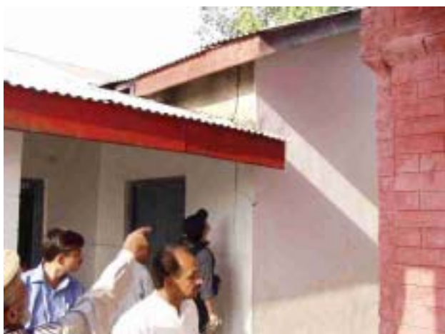
写真46 ブロック造壁隅角部のクラック
