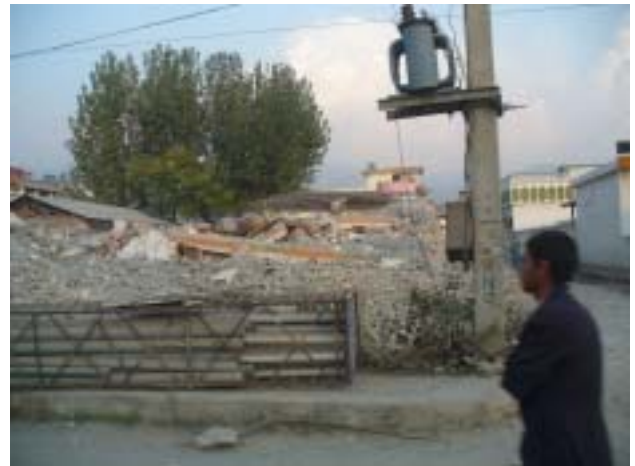
写真11 街道沿いの倒壊した建物
