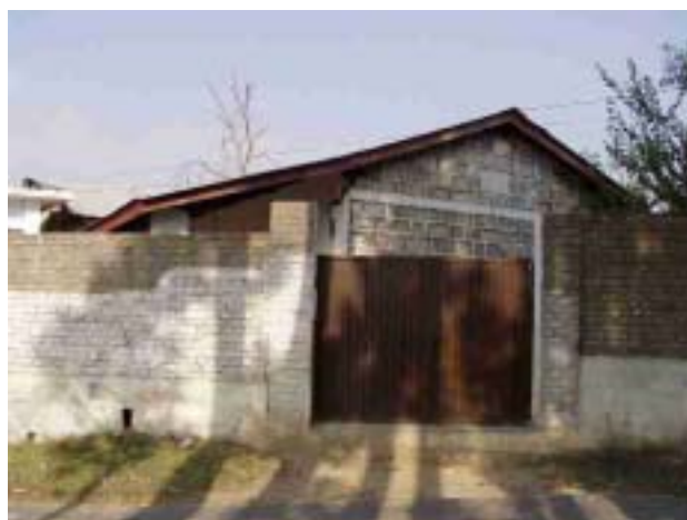
写真39 州立小学校外観
