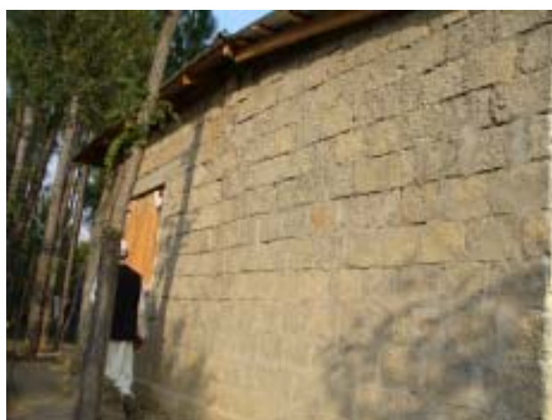
写真58 比較的整形なブロック （写真57の左側面）
