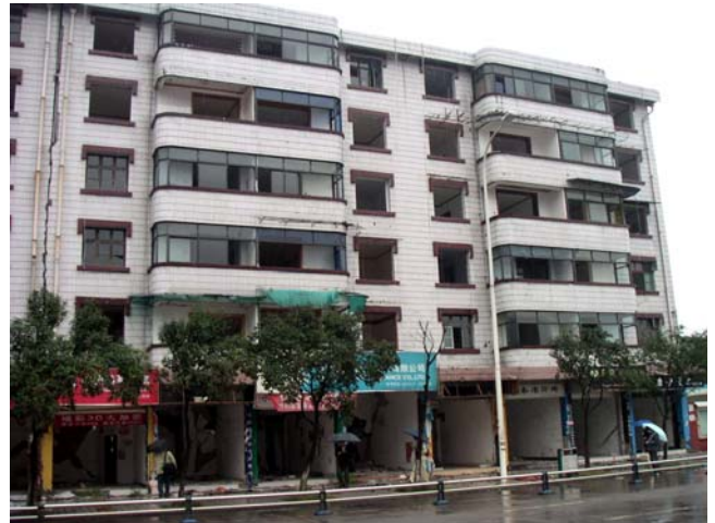
写真9 1階に被害が集中した建築物
