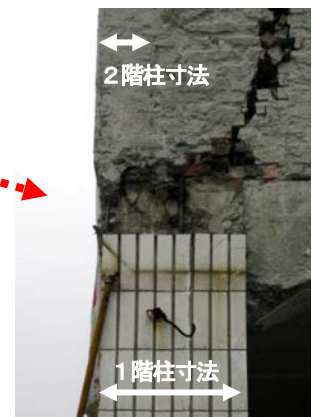
写真 18 2階で大きく減じられた柱の寸法（都江堰）
