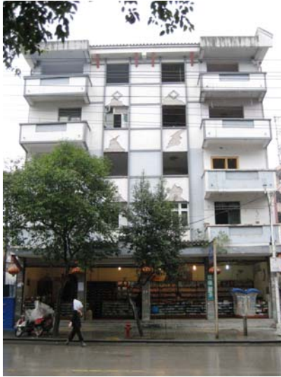
写真6 都江堰で一般的な1階に店舗を有する共同住宅
