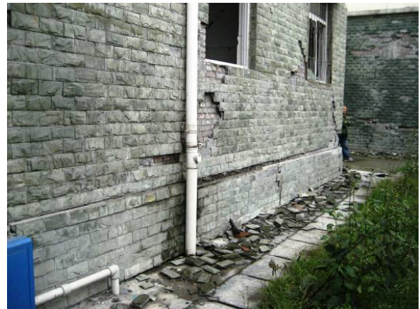
写真25 基礎と上部構造のずれ(映秀)
