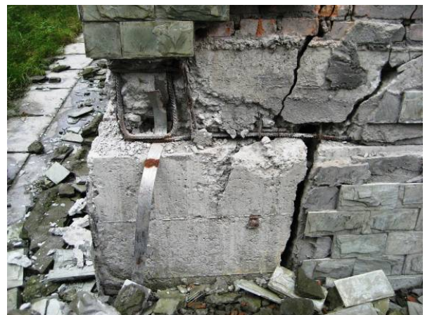
写真26 写真25の基礎と柱脚の詳細
