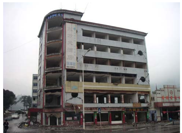
写真11 2階以上に被害が分散した建築物
