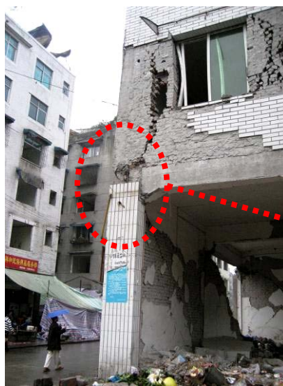
写真 18 2階で大きく減じられた柱の寸法（都江堰）
