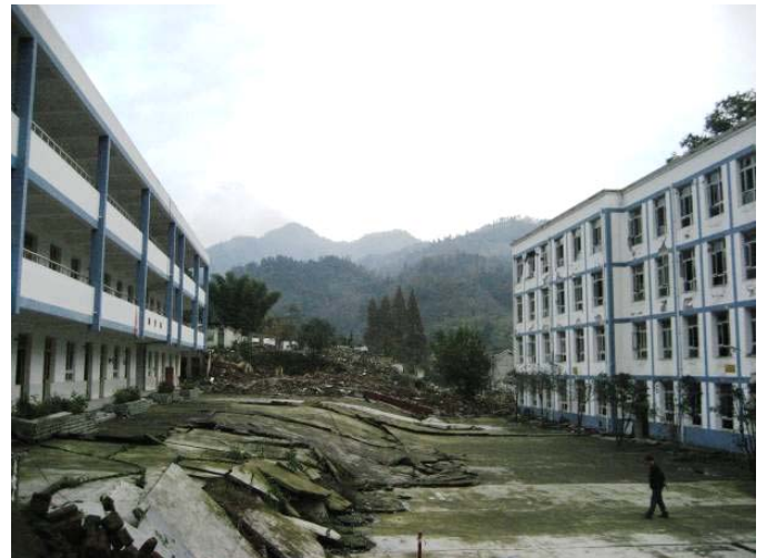
写真13 2棟の教室棟の間に露出した断層
