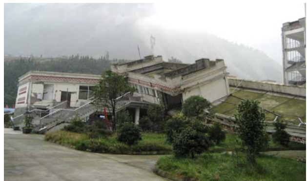
写真1 大きく傾いた校舎（映秀）
