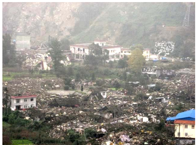
写真 5 ほとんどの建物が倒壊した映秀の様子
