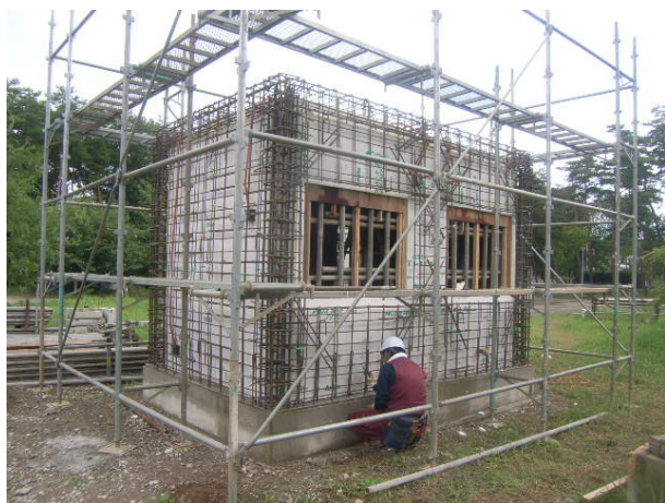
図26 システムⅡの検証実験に用いた試験建物
