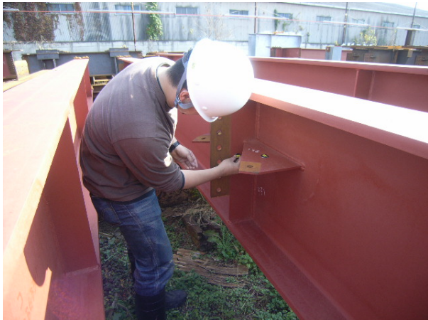
図 19 IC タグの貼り付け作業の様子
