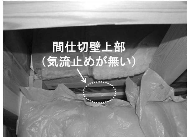
図4 壁の実況見分の事例
