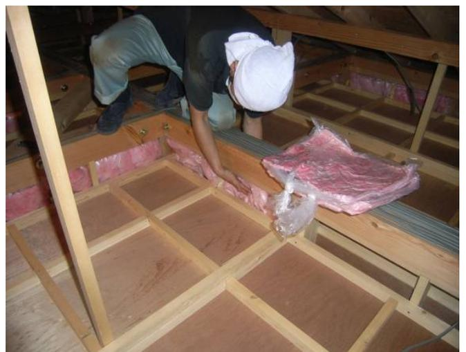
図 17 小屋裏の気流止め
