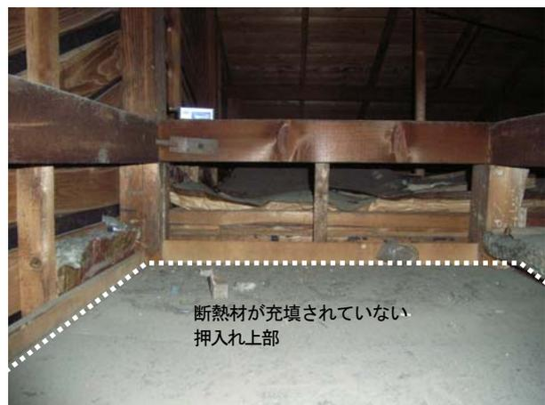
図6 挿入れ上部の断熱欠損の例
