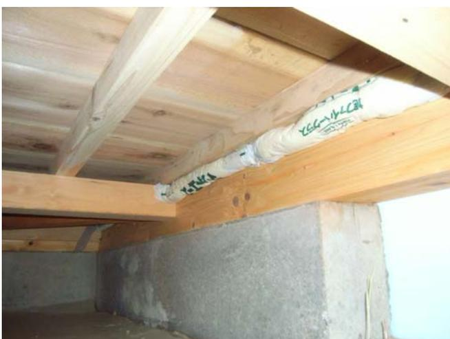
図 14 床下の気流止め
