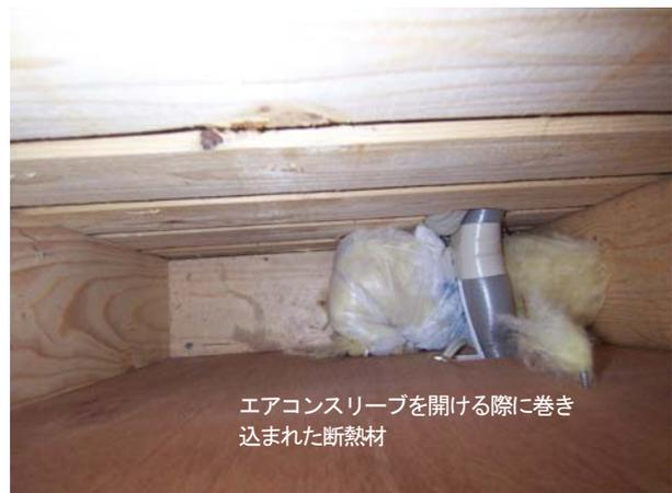
図5 エアコン設置工事の際に生じた断熱欠損の例
