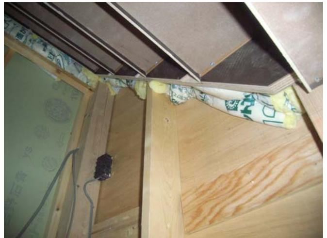
図 15 階段の側板に挿入
