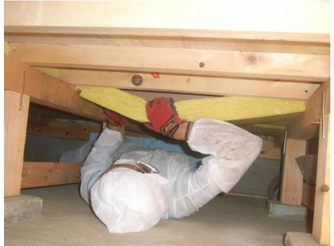
図18 根太間への断熱材挿入
