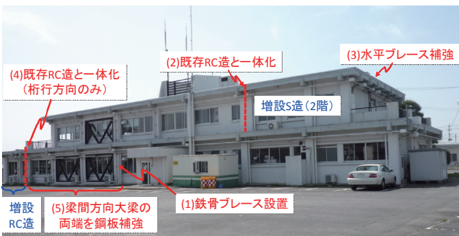
写真 1 本建築物の外観及び耐震補強の概要
