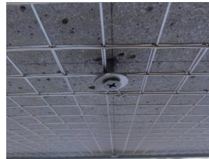
写真1 吹付け施工前のメッシュとアンカーの緊結状況
