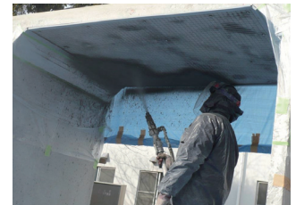
写真2 上面への吹付け施工状況
