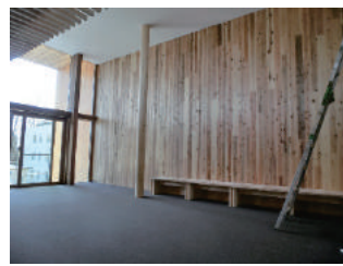
写真 1 6 m の通し壁
