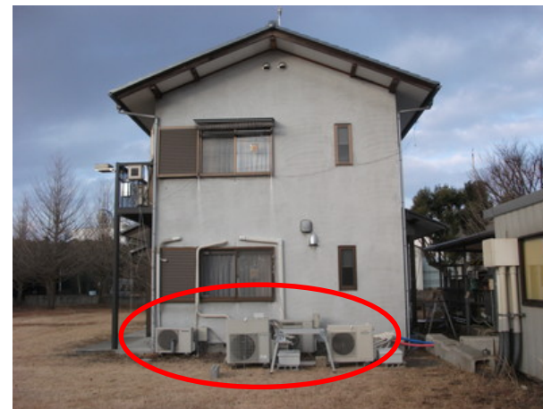
室外機設置状況
