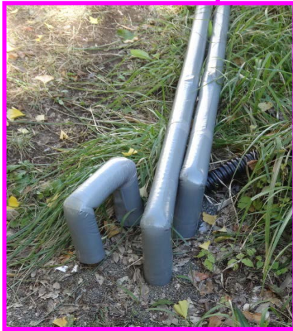
ボアホールから 配管立上部分
