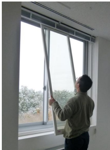
内窓設置の様子
