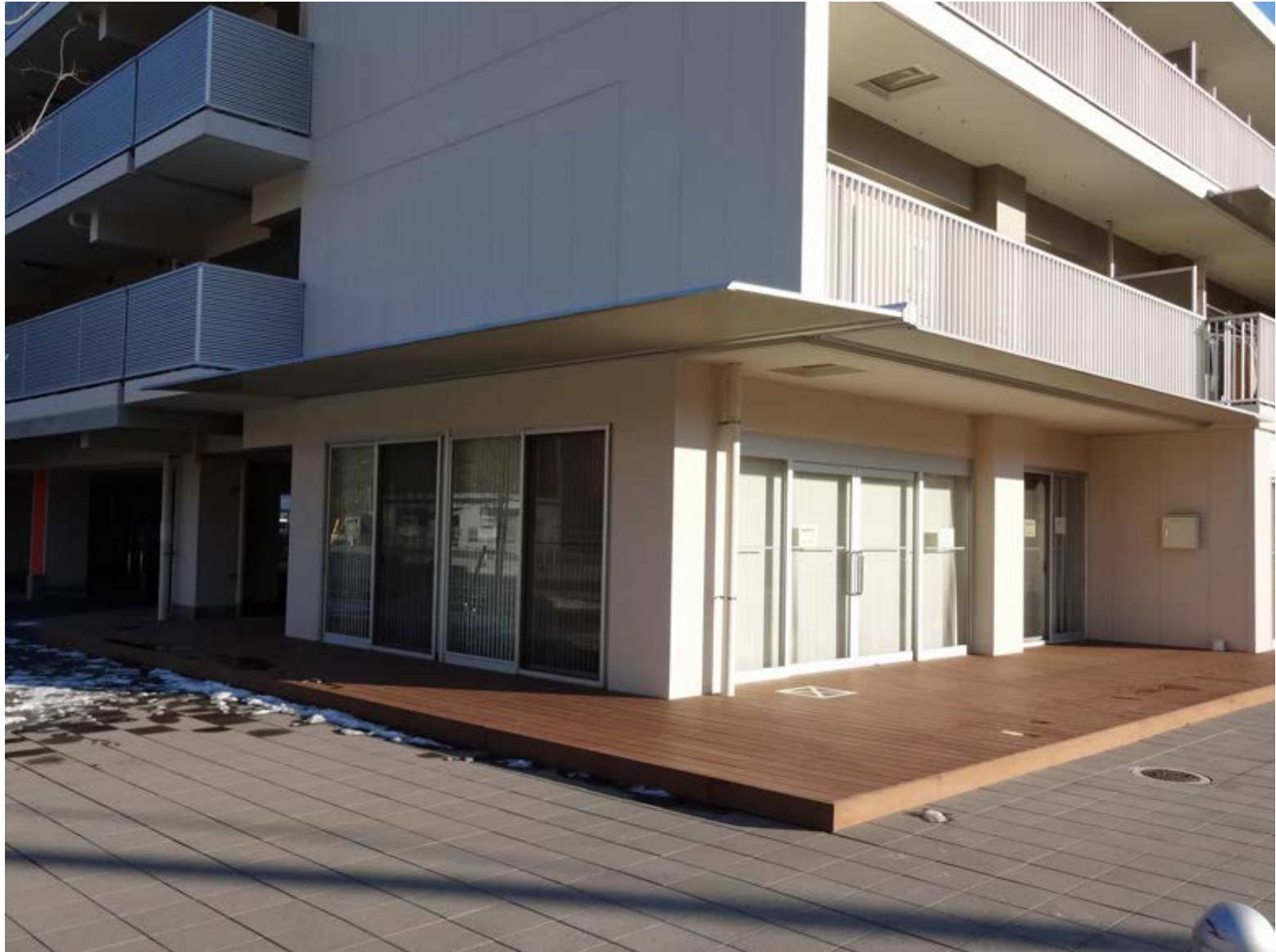
コミュニティプラザの外観
