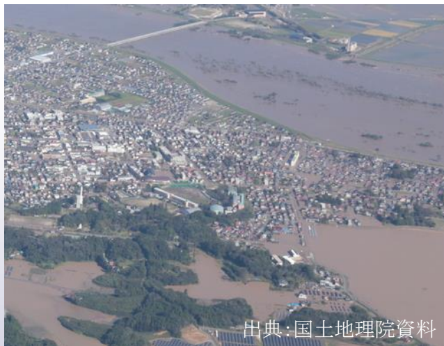
令和元年東日本台風による浸水被害
