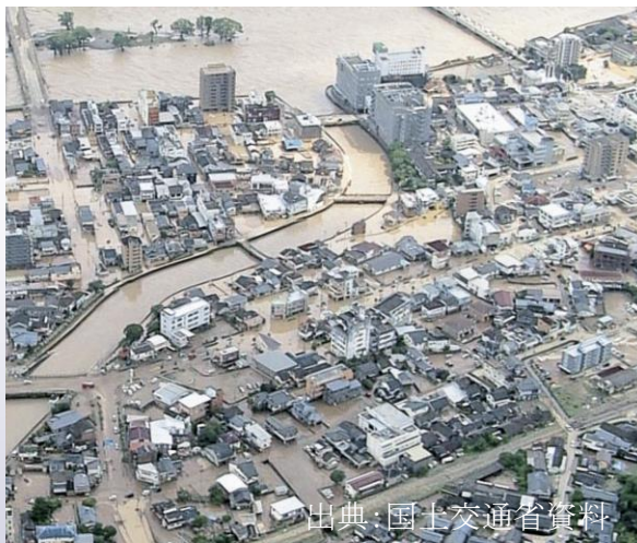
令和2年7月豪雨による浸水被害
