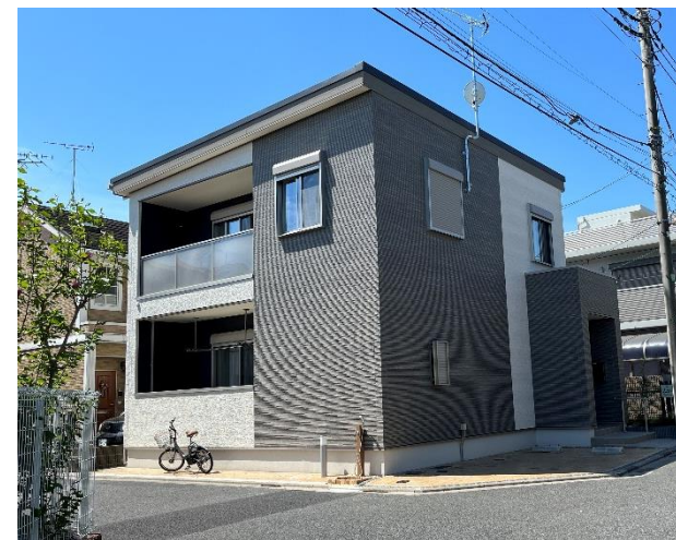
CLTパネル工法による2階建て住宅 (大東建託株式会社よりご提供)
