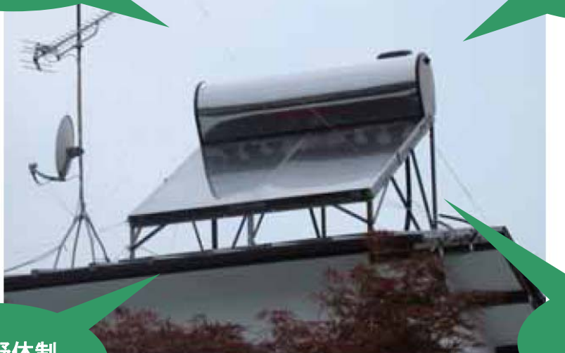
【既存太陽熱温水器の外観】
