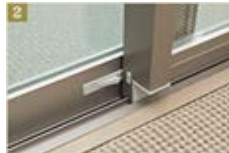
2 防犯に配慮しながら換気できる 自然換気ストッパー付きサッシ
