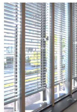
高断熱ガラスへの取替
