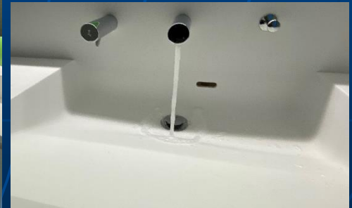
水量調整された跳ね返りの少ない 自動水栓
