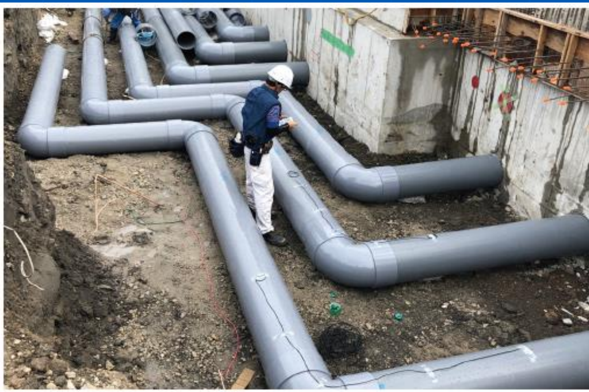
アースチューブ施工状況
