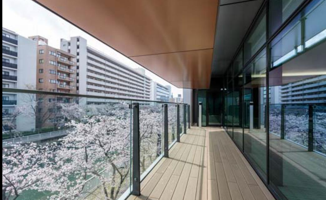
南面ファサード ～ウェルネスオフィスを構成する緑豊かなバルコニー～
