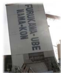
傾いた生コンプラント
